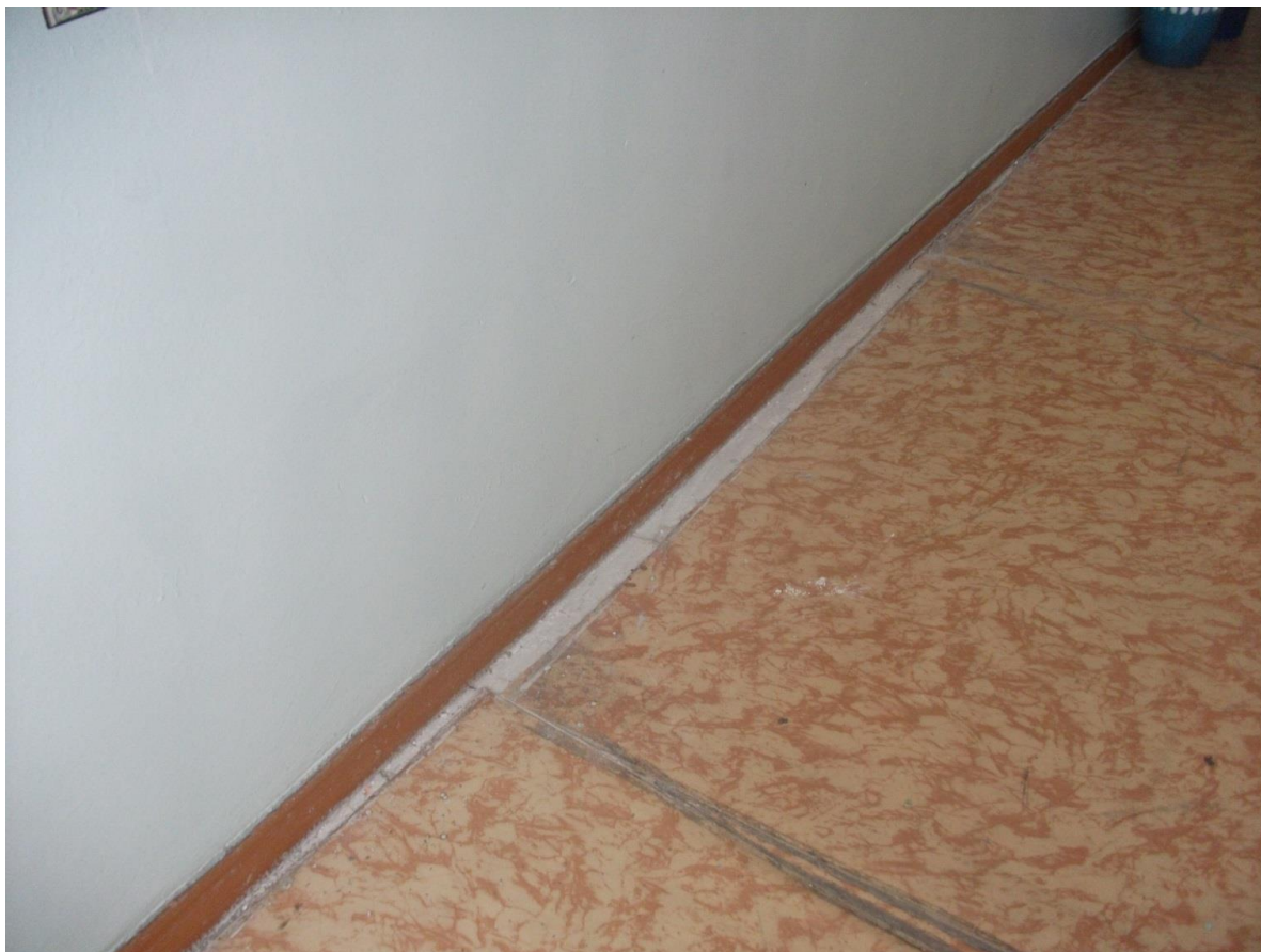
Кабинет русского языка до ремонта
